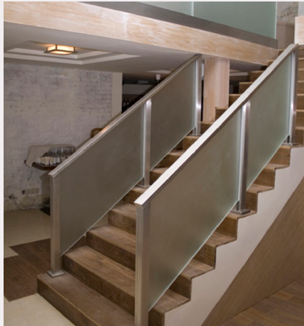
объект: ресторан Арт-Клумба поручень и стойки - нержавеющая сталь стекло satinato 10 мм закалённое
